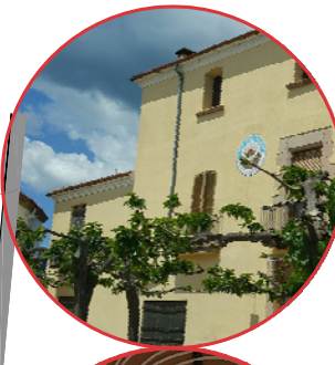
RECUPERACIÓ PATRIMONI BIOARQUITECTURA AUTOSUFICIÈNCIA ENRÈGICA
